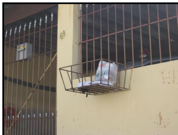
Figura 3.4-2. Coletores elevados em frente à residência
