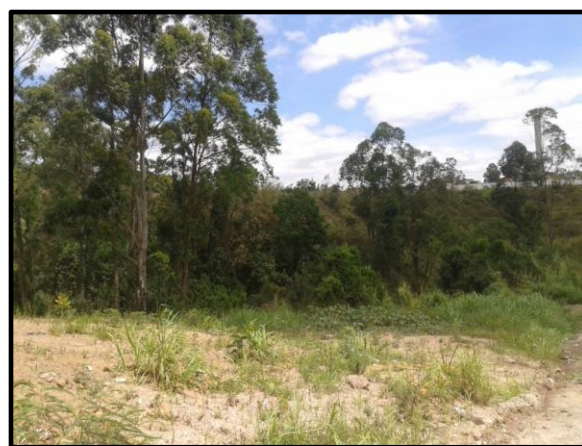
Figura 1.5-3 Vista lateral do talude . O córrego está nas região das árvores
