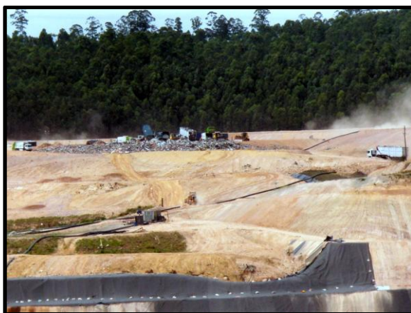
Figura 3.7-2. Figura da área operacional, mostrando a impermeabilização inferior
