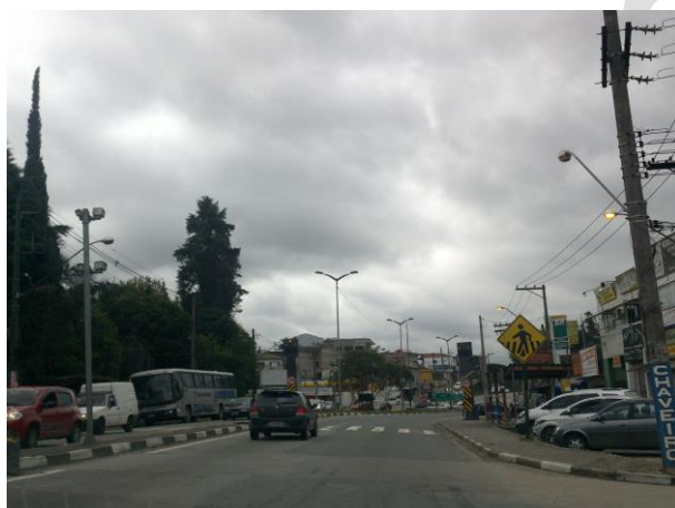
Figura 5.1-4: Travessia de pedestre, em nível, na Vila Gertrudes
