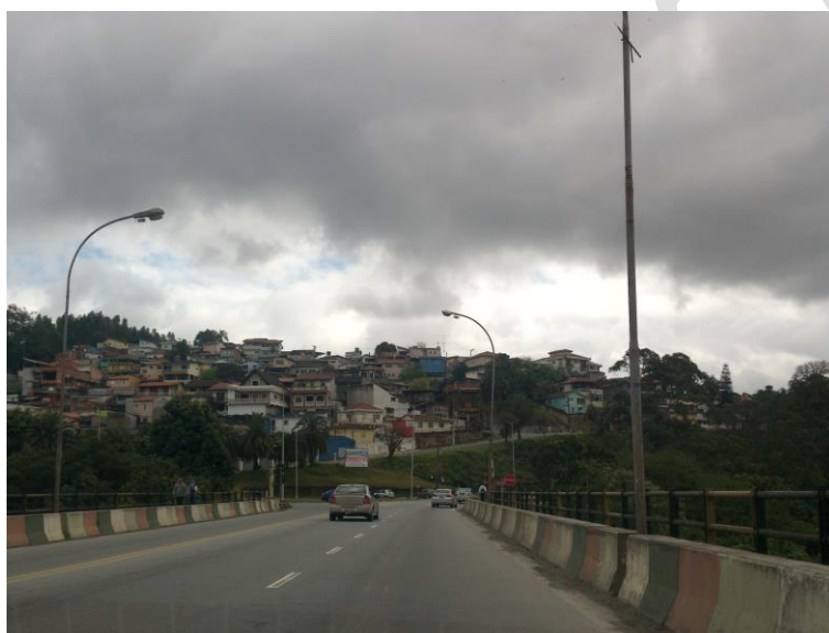
Figura 5.1.1-2: Viaduto Rua João Dártora
