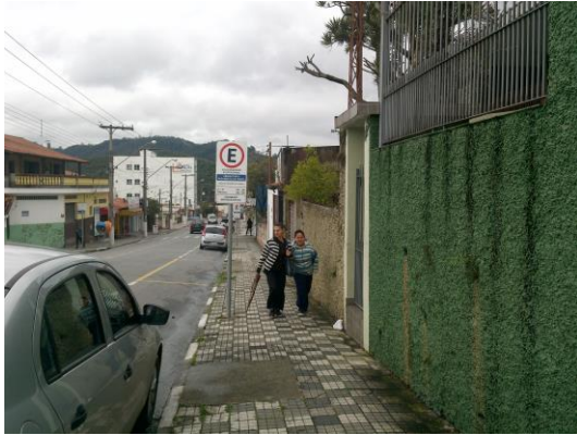
Figura 5.5.2-5: Tipologia de calçada no centro (Rua Guadalajara)
